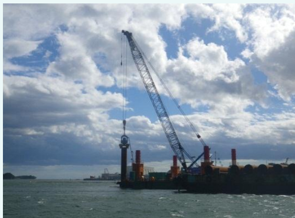
鋼管矢板打設状況（昼間）
