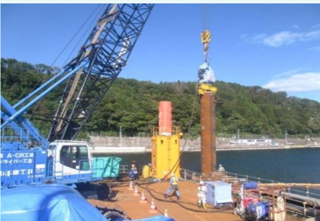
鋼管矢板打設状況（SEP台船上から）
