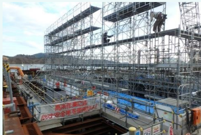
足場組立状況
