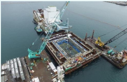
橋脚コンクリート打設状況
