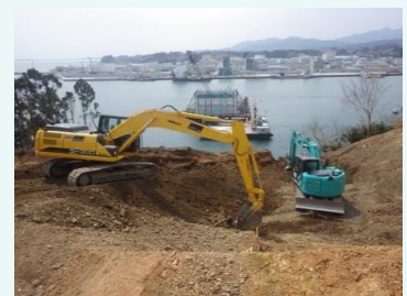
③A2橋台掘削状況
