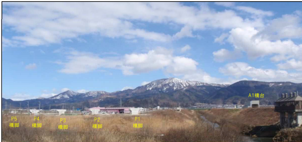
着手前全景【西側より】
