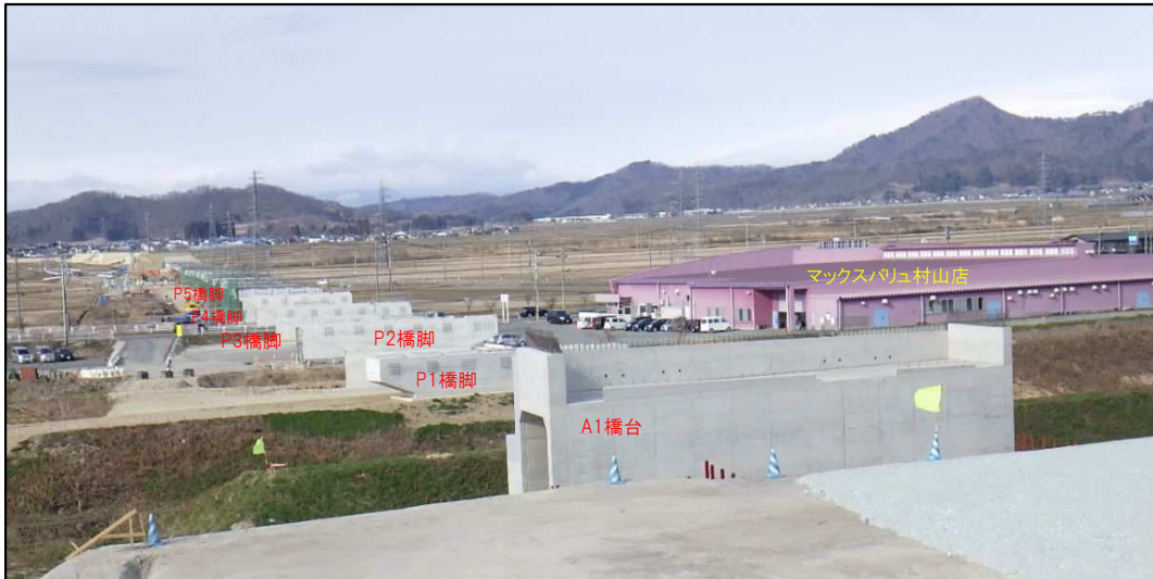
着手前全景【A1橋台背面より】
